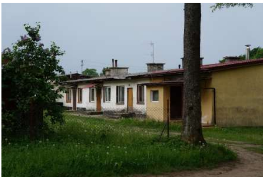
Fot. 53. Zabudowa mieszkalna w Naclawiu
