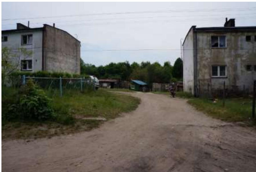
Fot. 59. Przestrzeń wspólna w zabudowie wielorodzinnej w Rzeczy Wielkiej
