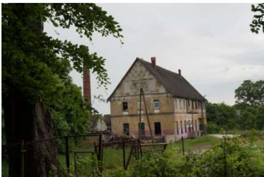
Fot. 34. Zły stan techniczny obiektów budowlanych
