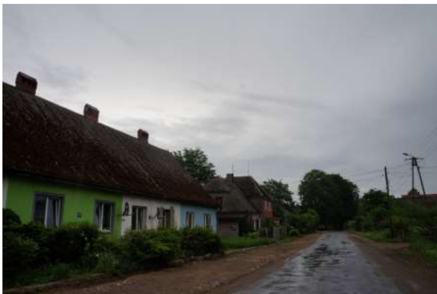
Fot. 33. Droga prowadząca przez miejscowość
