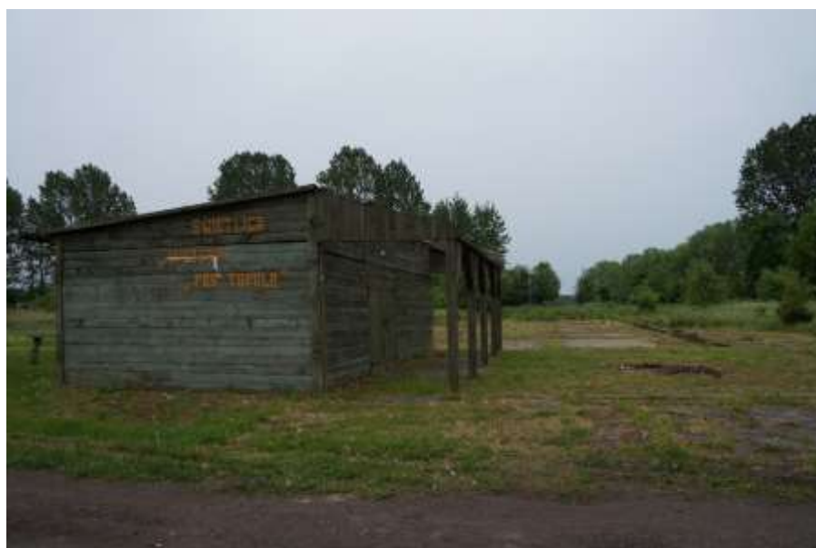
Fot. 40. Obiekt niefunkcjonującej świetlicy wiejskiej
