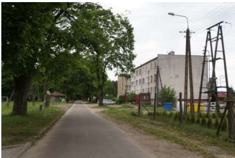
Fot. 62. Zabudowa wielorodzinna w Rzeczy Wielkiej
