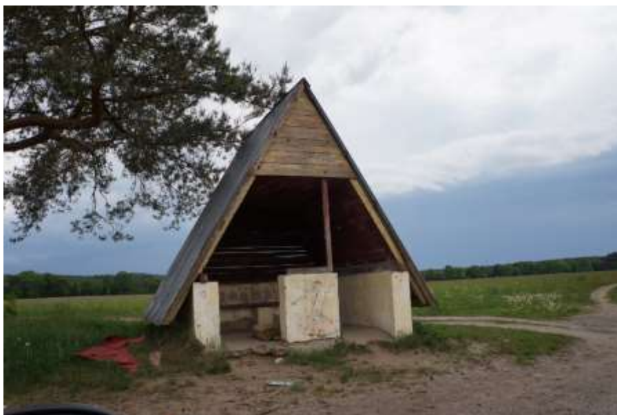
Fot. 65. Przystanek autobusowy w Rzeczycy Małej
