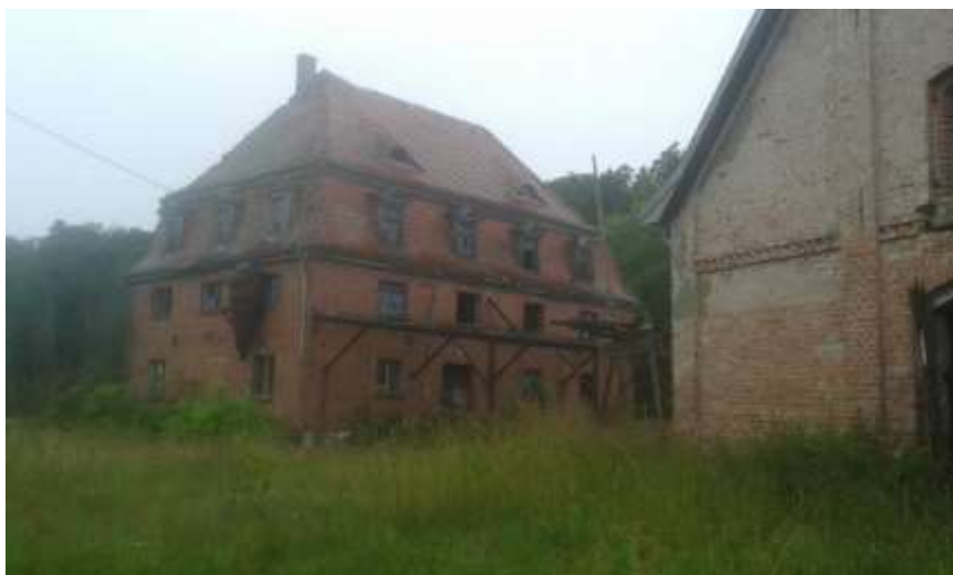
Fot. 80. Zabudowania w przestrzeni pałacowej
