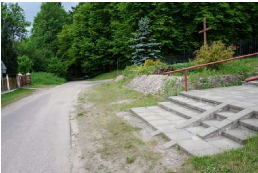
Fot. 61. Przestrzeń przy kościele w Rzeczy Wielkiej
