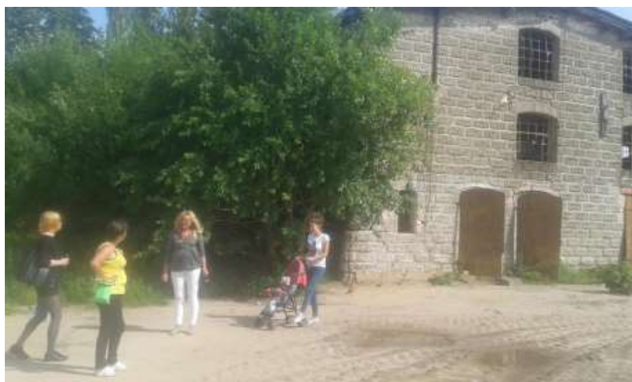
Fot. 76. Przestrzeń i obiekty, gdzie docelowo może powstać świetlica wiejska w Cetuniu
