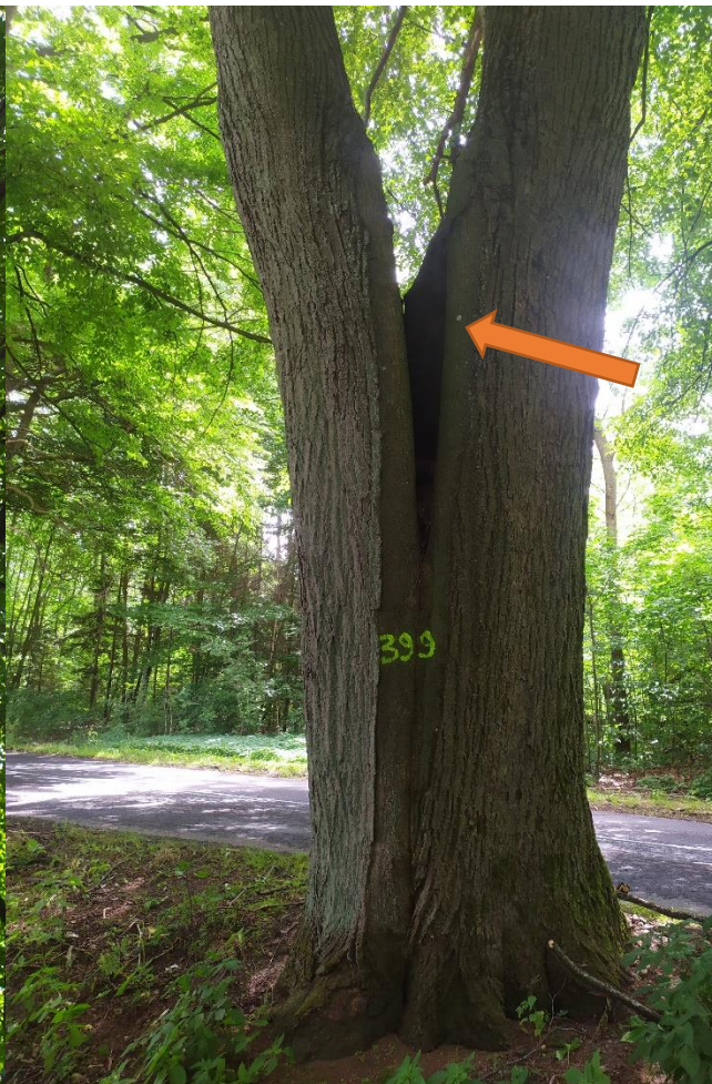
Rozwidlenie do zabezpieczenia
