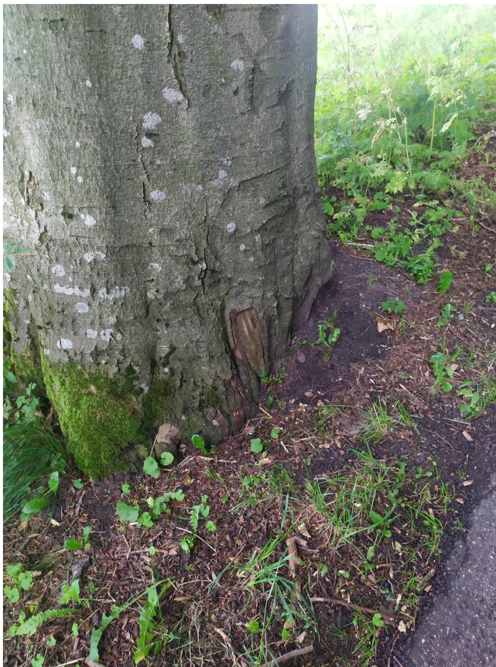
Uszkodzone nabiegi korzeniowe
