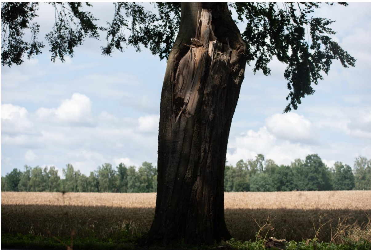
Najczęściej rozkładowi ulegają partie od strony jezdni, co związane jest z uszkodzeniami korzeni. Kończy się to wylamaniem przewodników.
