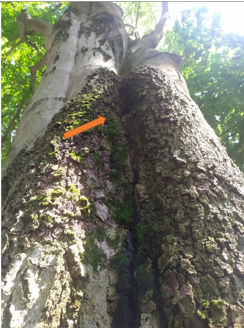
Rozwidlenie do kontroli i ewentualny montaż wiązań zabezpieczający obydwa przewodniki
