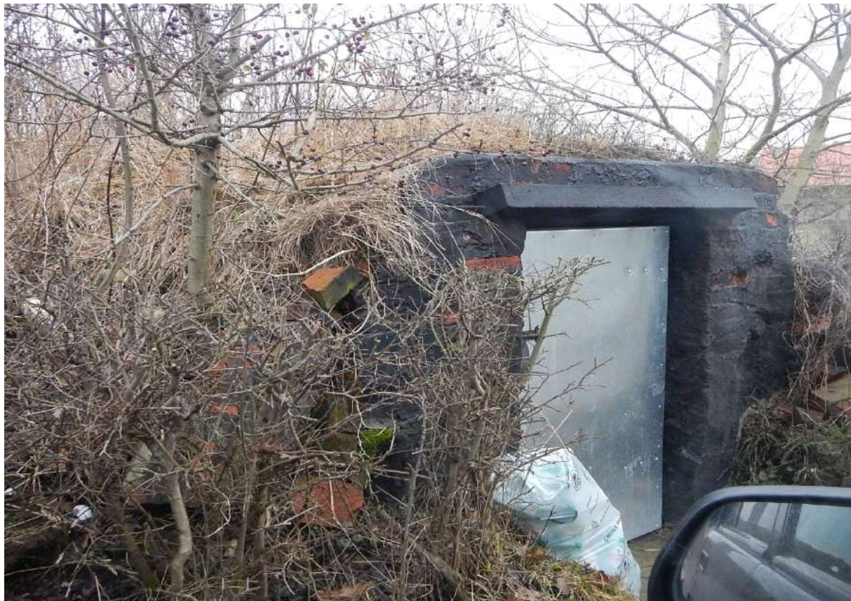
Fot. 6. Piwnica (ziemianka) w rejonie Żydowa. Miejsce uszczelnione, niedostępne dla nietoperzy.
