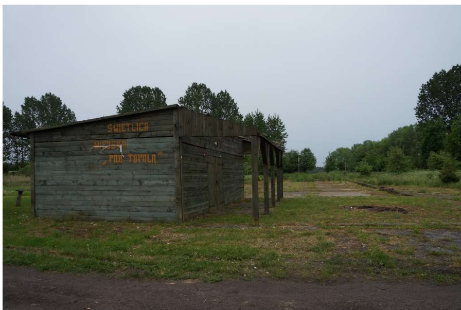
Fot. 40. Obiekt niefunkcjonującej świetlicy wiejskiej
