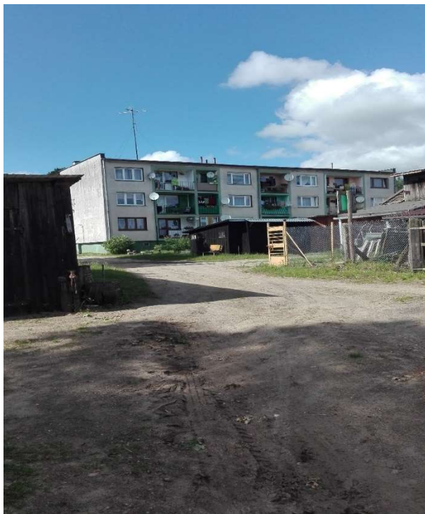
Fot. 72. Bloki mieszkalne w Rzeczycy Wielkiej
