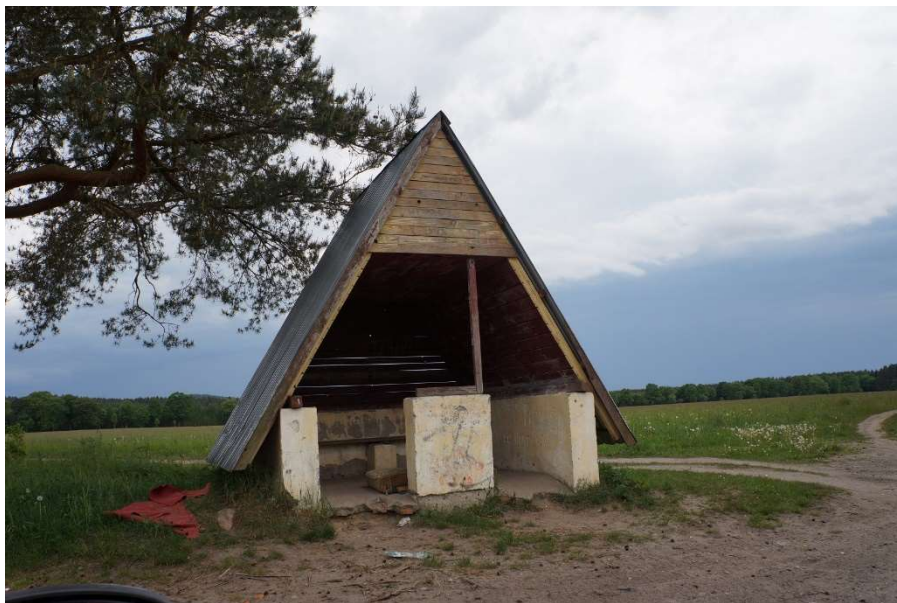
Fot. 65. Przystanek autobusowy w Rzeczycy Małej
