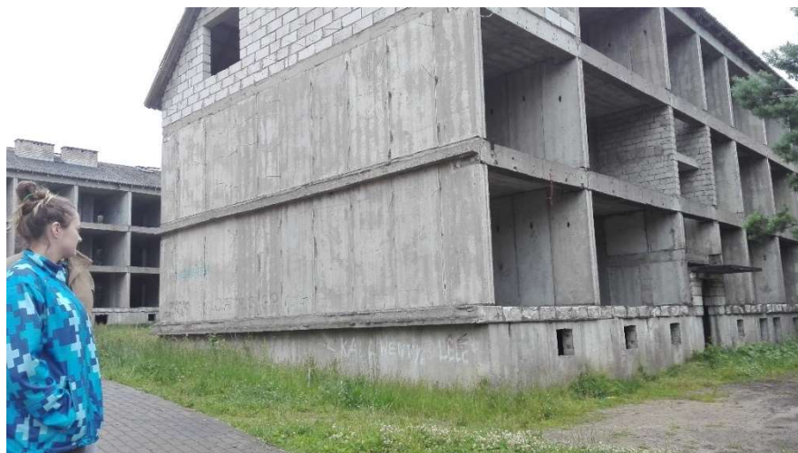
Fot. 78. Widok pustostanów obok mieszkań socjalnych
