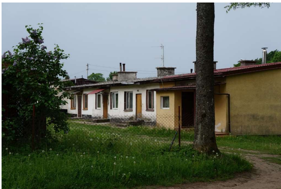
Fot. 53. Zabudowa mieszkalna w Naclawiu
