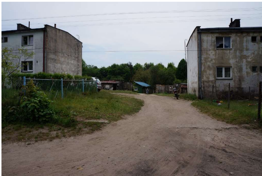
Fot. 59. Przestrzeń wspólna w zabudowie wielorodzinnej w Rzeszycy Wielkiej
